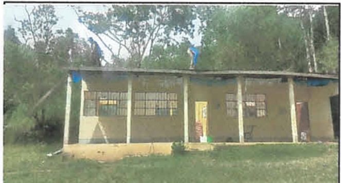
MANTENIMIENTO DE ESTRUCTURA Y CAMBIO DE TECHO
