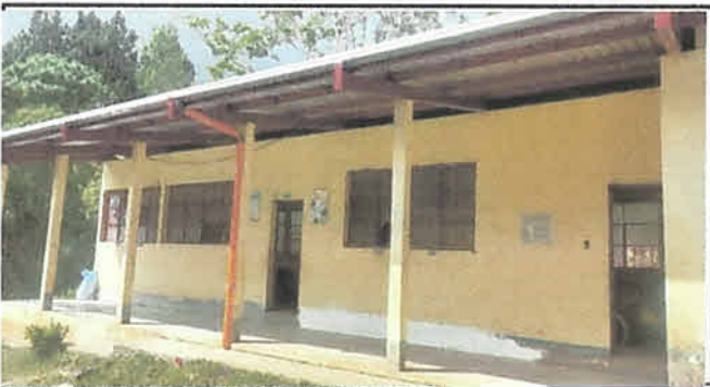
MANTENIMIENTO DE BALCONES Y VIDRIOS
