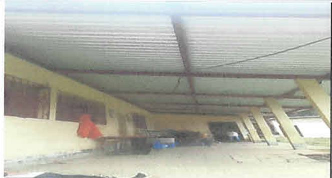
CAMBIO DE PISO
