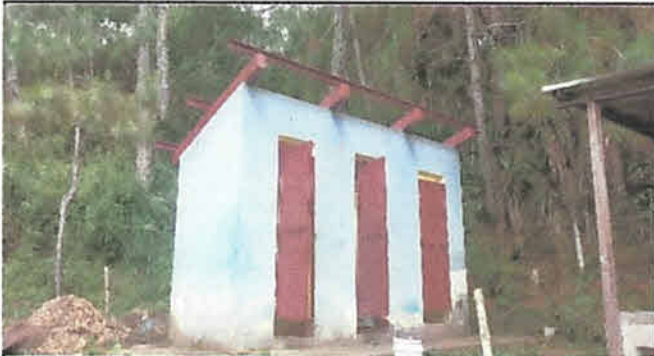
MANTENIMIENTO REMOZAMIENTO DE ESTRUCTURA Y TECHO BAÑO
