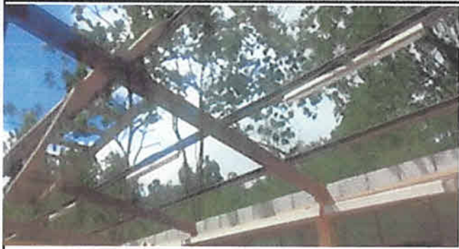
REMOZAMIENTO DEL TECHO Y MANTENIMIENTO DE LA ESTRUCTURA
